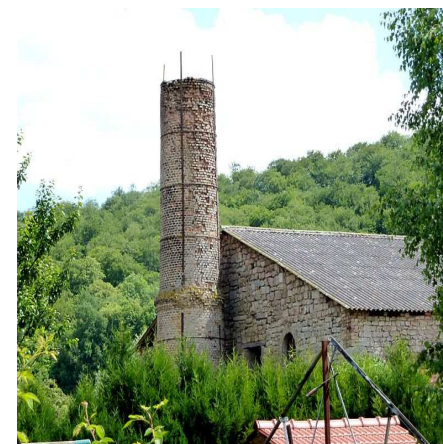
Tuilerie de Rangéval (wikipédia)
